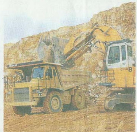
Der Bagger befüllt den Muldenkipper. Fotos: Mertin
